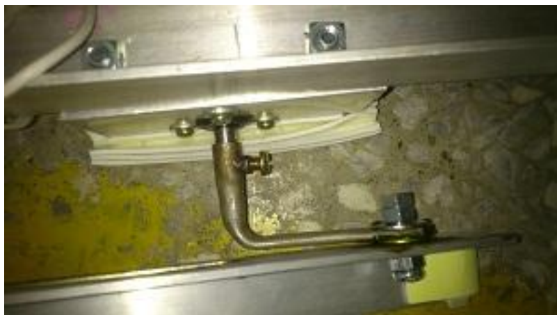
圖 6 不銹鋼彎管及馬達軸的焊接
