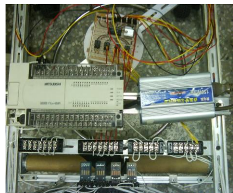
PLC、訊號轉換器、交流轉直流轉換器
