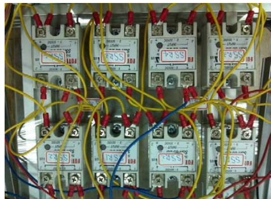
圖八· SSR 固態繼電器
