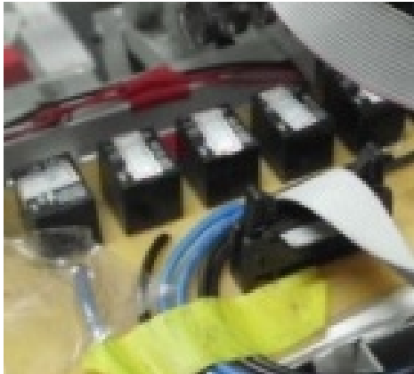
底盤傳動為大型繼電器與工配電路，能夠承受較大負載，使底盤具有足夠的穩定性。
