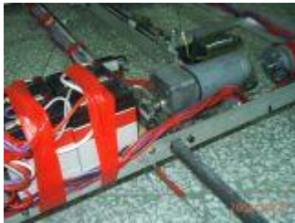
(圖 8) 四顆 6V 電瓶串接主電源
