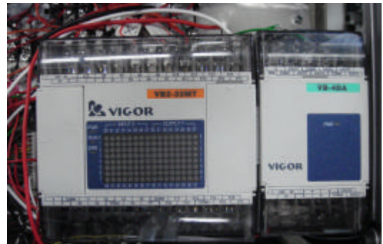
圖 4 PLC 主機與 DA 模組照片
