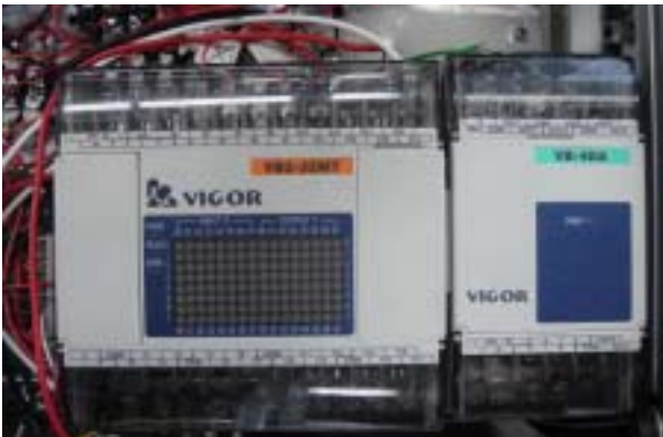
圖 6 PLC 主機與 DA 模組照片
